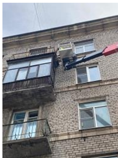
ул. Фрунзе дом 1, ремонт балконов с вышки.
